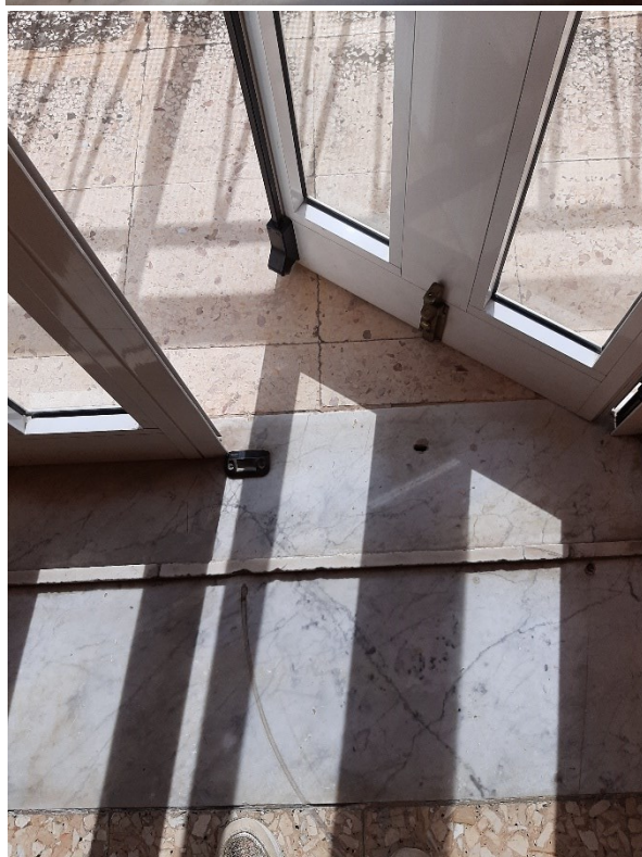
Uscita di emergenza piano primo
