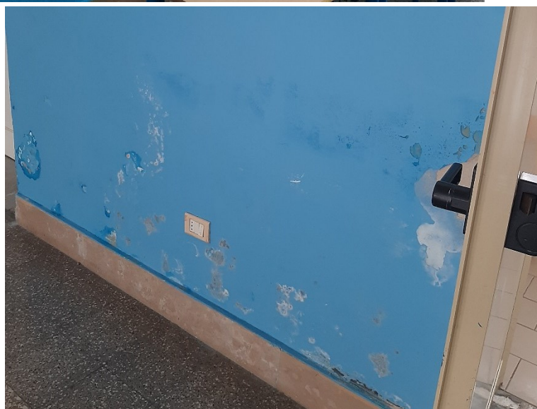
Aule e corridoi Pad.A
