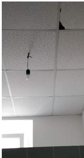
Punti Luce Servizi igienici Pad. A, pannelli controsoffitto in alcune zone danneggiati
