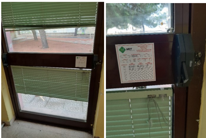
Uscita di emergenza priva di maniglione antipánico, aula 1°D
