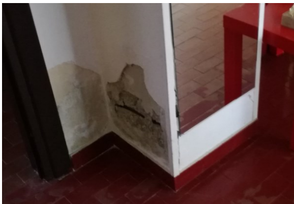
Pilastro ingresso palestra
