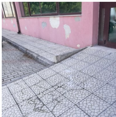
Rampa d'ingresso esterna
