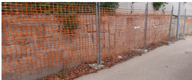
Muro di confine
