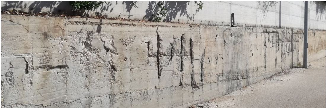
Muro di confine
