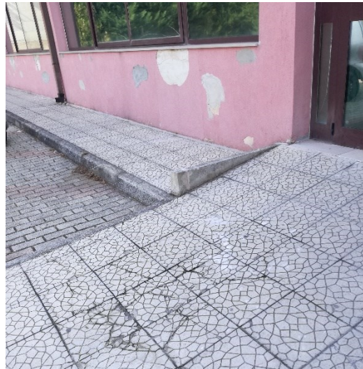
Rampa d'ingresso esterna
