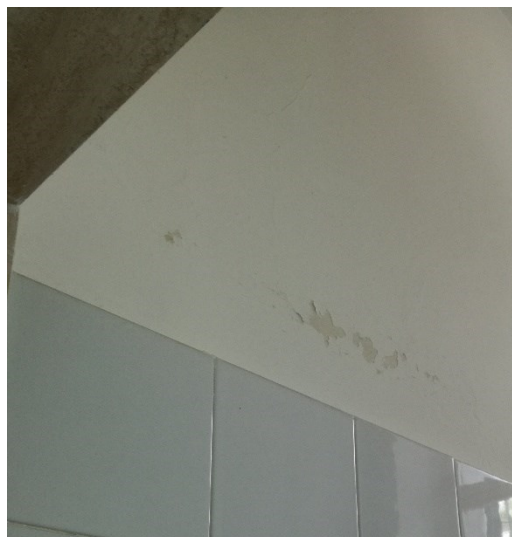
Intonaco deteriorato in alcuni locali, soprattutto del piano secondo
