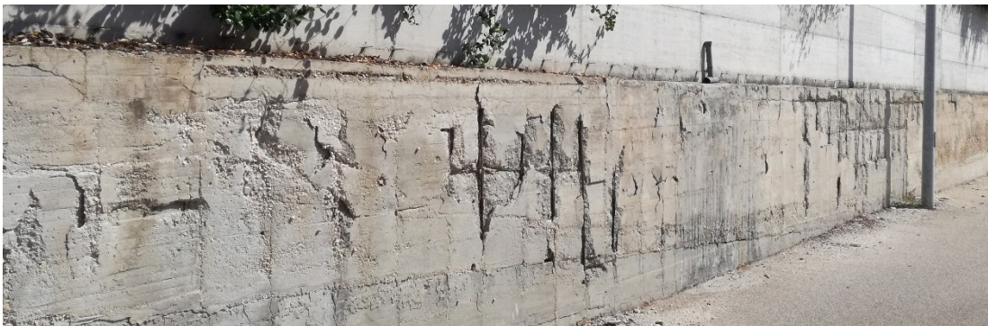
Muro di confine
